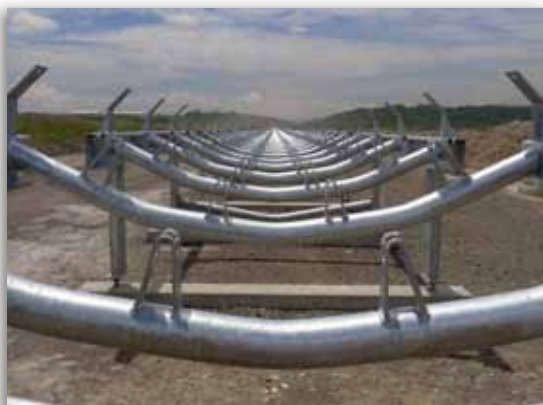
Pekerjaan Engineering di lokasi konveyor lapisan penutup
